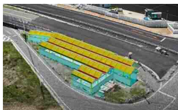
イメージ:富海地下道施工におけるAR技術
