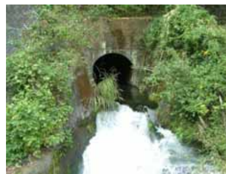
和田分水(川上ダム上流)
