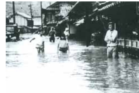
旧・徳地町大字堀・堀島地川鉄橋付近 浸水状況 (昭和26年7月洪水)
