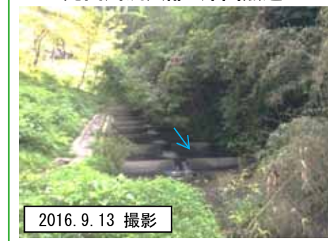
先山川流入部 床固魚道
