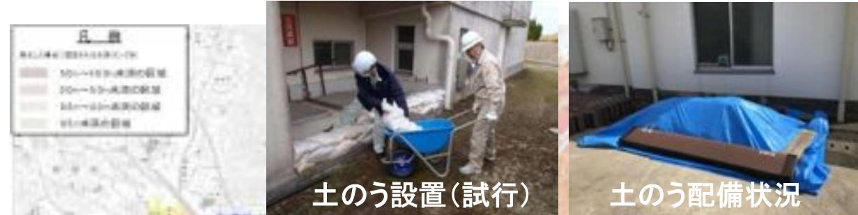
全27施設のうち、想定最大規模の浸水によって排水施設の停止が想定される施設は11施設。このうち、簡易的な対策が可能な4施設で対策を完了した。
