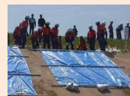
シート張り工
