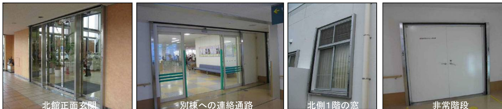
止水板のための角落し設置
