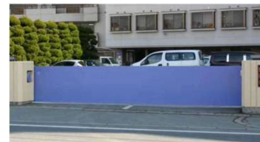
指定耐水施設での耐水化対策 (浸水防止壁)の事例
