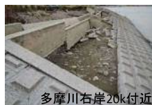
多摩川右岸20k付近
