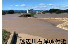
越辺川右岸0k付近
