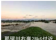
那珂川右岸28k6付近
