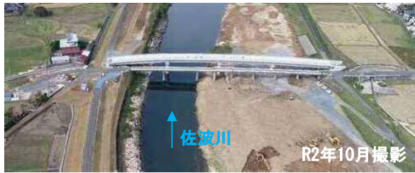
① 築堤（睦美橋の架替え）
