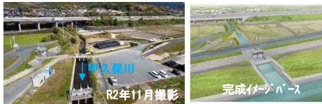
② 築堤（甲久保支川処理）
