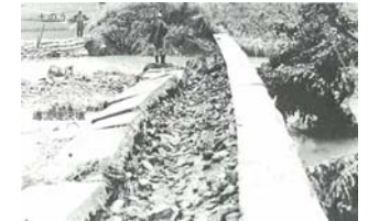
徳地町麻生・麻生頭首工
