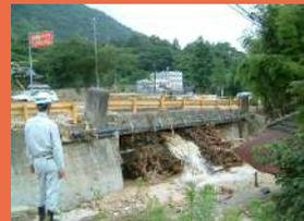
森林の持つ保水機能や樹木の根っこの持つ力が弱くなると山が崩れ、左の写真のように土石流が発生したり、右の写真のように流された木が川に出て橋にひっかり大きな被害につながってしまうことがあります。(写真は平成21年7月21日の佐波川流域内の災害事例です)
