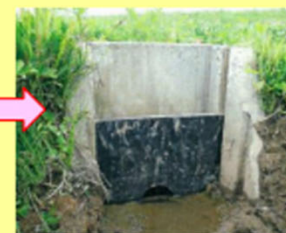
水戸板設置状況
