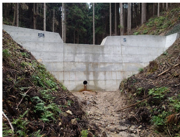
治山ダム 完成状況
