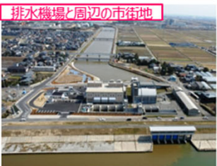
排水機場と周辺の市街地
