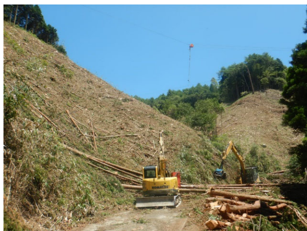
保護伐作業 搬出状況
