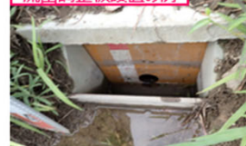
流出調整板設置の例
