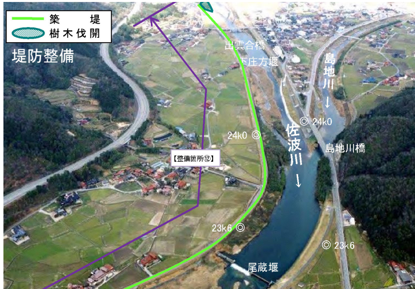
山口市庄方地区、堀地区
