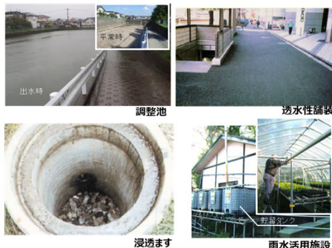
雨水貯留浸透施設の例
