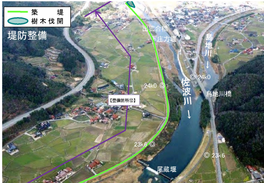
山口市庄方地区、堀地区
