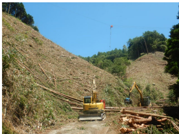
保護伐作業 搬出状況
