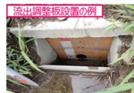
流出調整板設置の例
