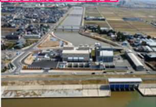
排水機場と周辺の市街地
