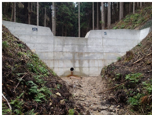
治山ダム 完成状況
