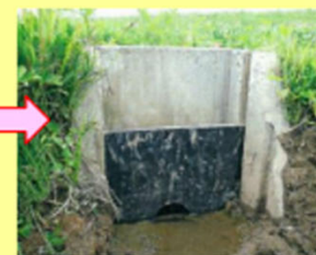
水戸板設置状況
