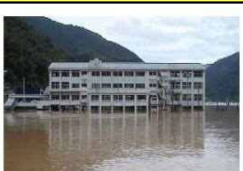
H26. 8 避難所2階の浸水(徳島県)
