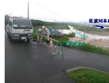
甲久保川合流点における浸水状況
