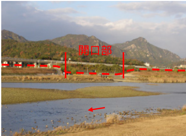
開口部の例 (甲久保川合流部)
