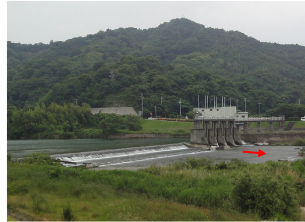
固定堰の例 (防府総合用水堰)
