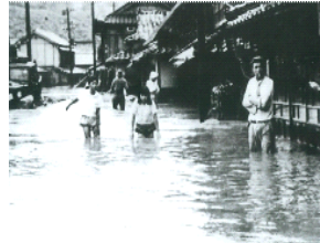
堀島地川鉄橋付近 (S26洪水)
