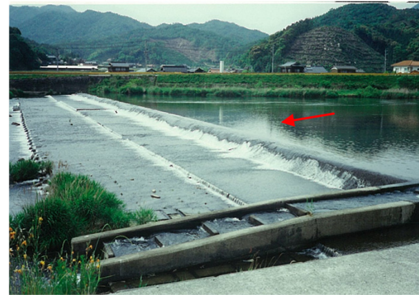
固定堰の例（西大津堰）
