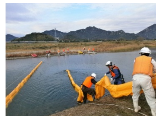
水質事故対応状況
