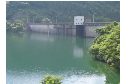
平常時の島地川ダム湖（平成25年7月撮影）
