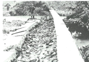
麻生頭首工付近 (S47洪水)
