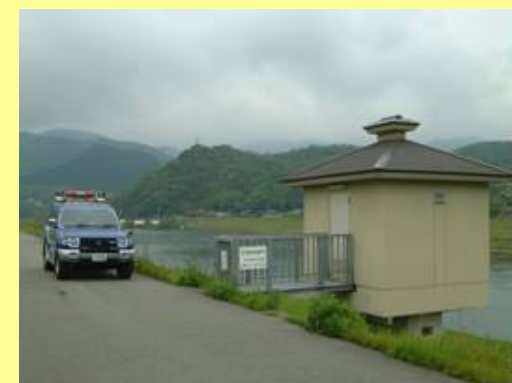
巡視車によるパトロール状況
