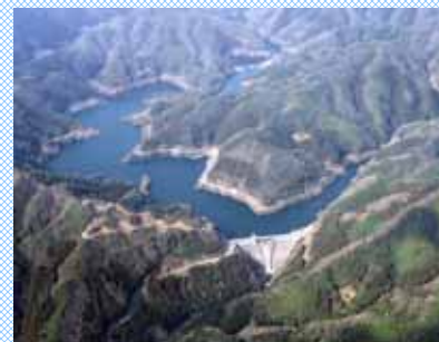
島地川ダム(S56.3完成)
