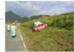
堤防点検の実施状況
