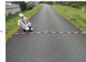
堤防の点検状況
