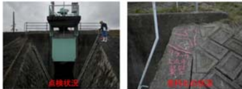
樋門の老朽化の状況
