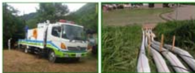
排水ポンプ車の活動状況
