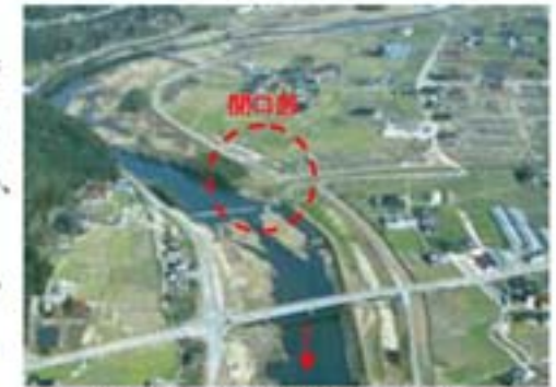
開口部の例（古森川合流部）
