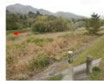
樹木繁茂の状況
