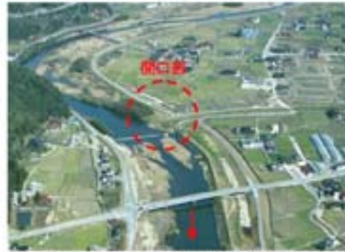
開口部の例（古森川合流部）
