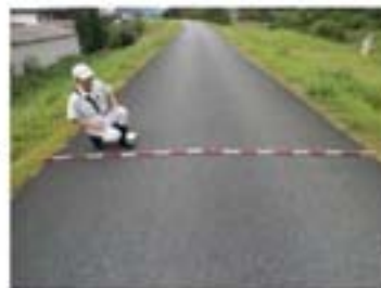
堤防の点検状況
