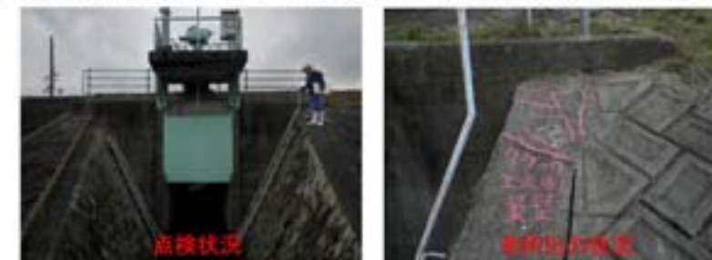
樋門の老朽化の状況
