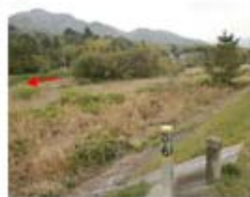
樹木繁茂の状況
