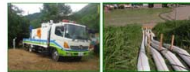
排水ポンプ車の活動状況
