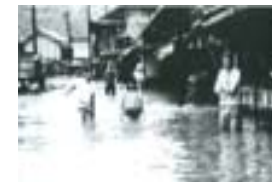
堀島地川鉄橋付近(S26洪水)
