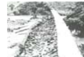
麻生頭首工付近(S47洪水)
