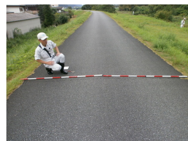
堤防の点検状況
