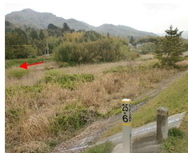
樹木繁茂の状況
