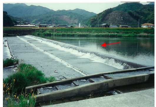
固定堰の例（西大津堰）
