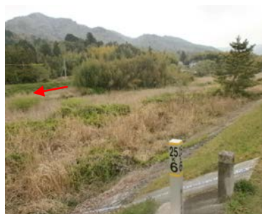
18 河道内に繁茂する樹木(上庄方堰上流)
