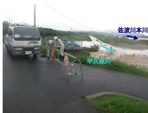
甲久保川合流点における浸水状況
