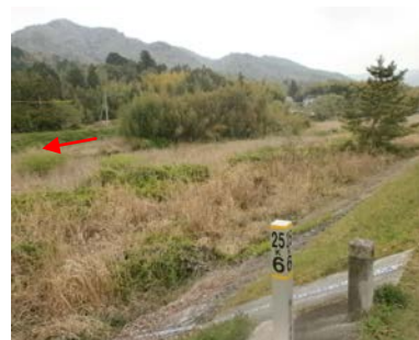
樹木繁茂の状況
