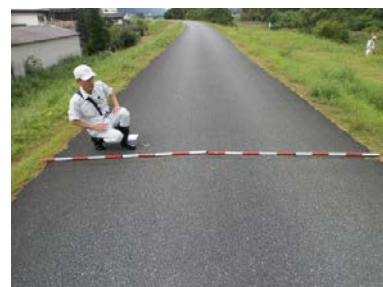
堤防の点検状況
