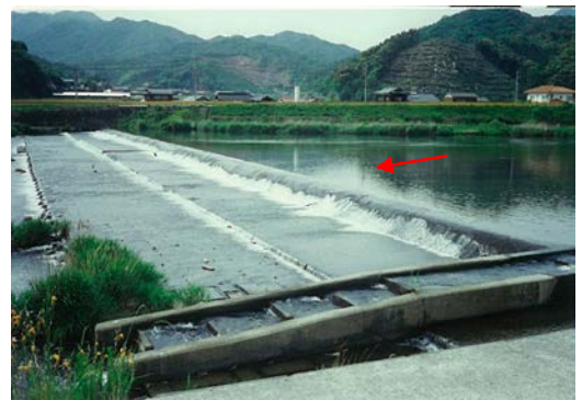
固定堰の例（西大津堰）
