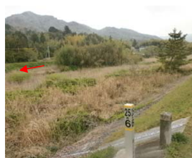
樹木繁茂の状況
