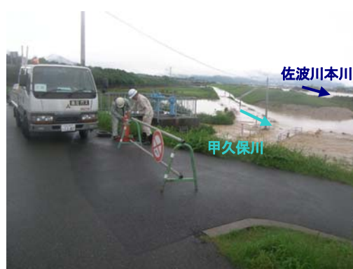
甲久保川合流点における浸水に伴う坂路への進入禁止措置状況
