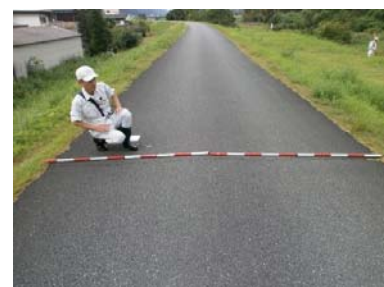
堤防の点検状況
