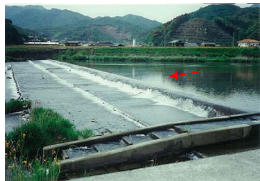
固定堰の例（西大津堰）
