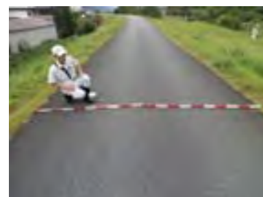
堤防の点検状況
