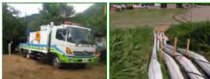
排水ポンプ車の活動状況
