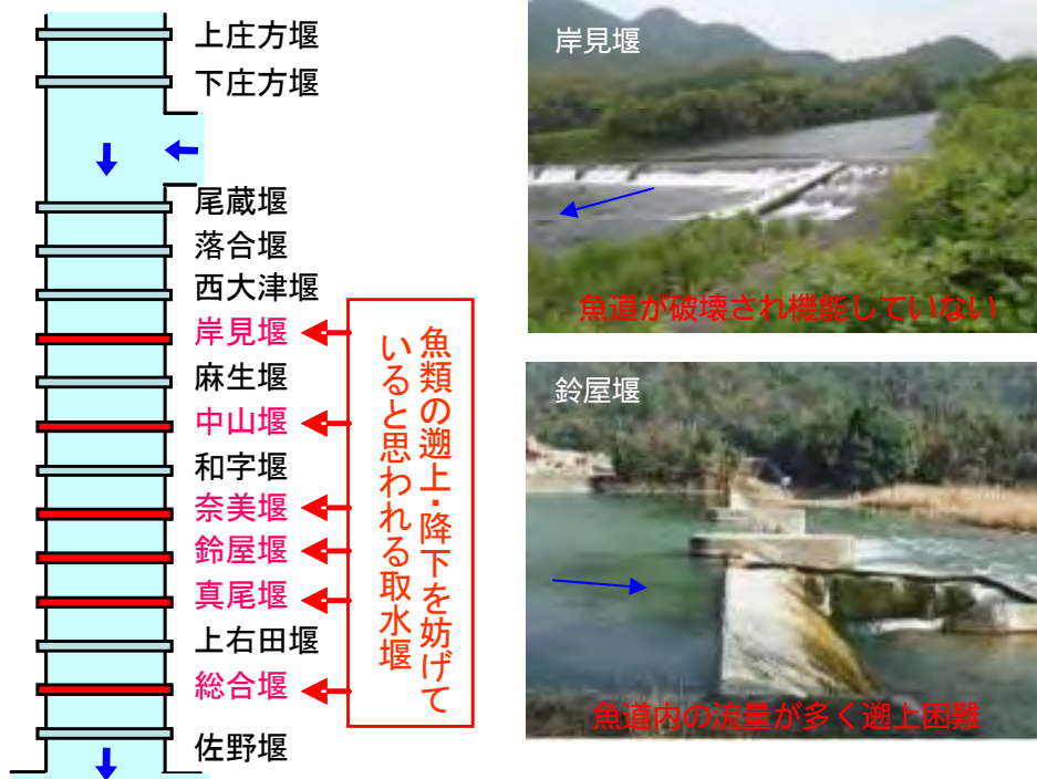
図3.2.3 魚類等の遡上・降下を妨げていると思われる取水堰
