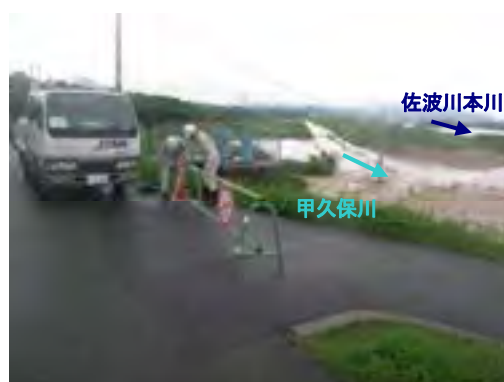
甲久保川合流点における浸水に伴う坂路への進入禁止措置状況
