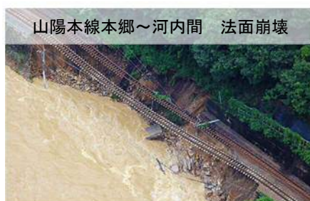
写真 1-2 平成 30 年 7 月豪雨 法面崩壊及び浸水状況【広島県】
