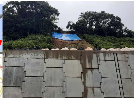
応急対策完了状況 (大型土嚢、ブルーシート設置)
