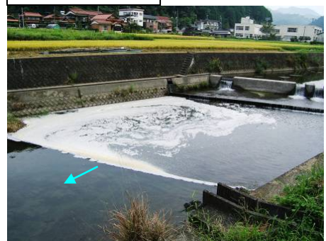
フェンスを設置
