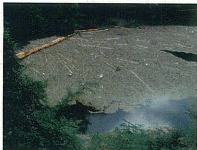
梅雨前線による今回の大雨で大量のゴミがダム湖内に流れ込みました。ダムでは貯水池内にフェンスを設置してこれらのゴミが下流に流れ出さないようしており、このフェンスに溜まったゴミは船などを使用して取り除いて処分します。
