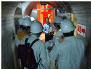
利水副バルブ室前
