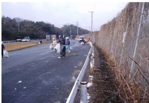
きれいになった路肩付近の状況
