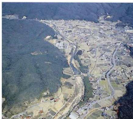
①小瀬川上流部(39K付近)
